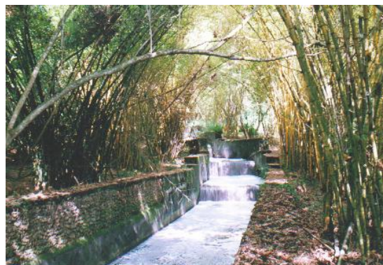
Fotografía 19. Estructura de Vertimiento La Argelia - Bucaramanga
